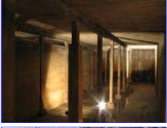
Brandenburg: Marienberg Trinkwasserbehälter
