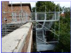
Brandenburg: Fluchttreppenanlage am ehemaligem Stadtbad
