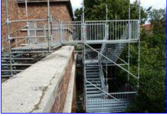
Brandenburg: Fluchttreppenanlage am ehemaligen Stadtbad
