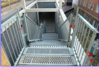
Brandenburg: Fluchttreppe am Klinikum
