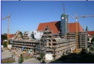
Leistungsangebote Die Position des obersten Bodens ist das Maß aller Dinge: Hier entscheidet sich, wie einfach später die verschiedenen Handwerkerarbeiten vom Gerüst aus durchgeführt werden können. Denn natürlich benötigt der Dachdecker andere Arbeitsbedingungen als der Maurer. Der Gerüstbauer ist also Vermittler zwischen den einzelnen Handwerksbereichen.
